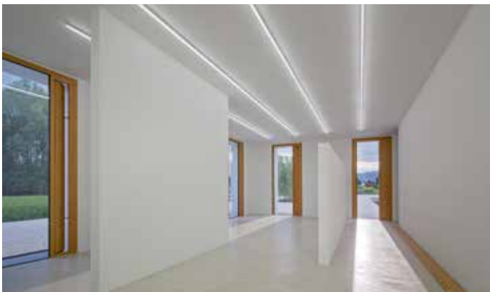
Abbildung 2.12: Das Gebäude 2226 in Lustenau von Baumschlager Eberle Architekten. Fenster mit seitlichen Lüftungsklappen. (Foto: archphoto.inc)
