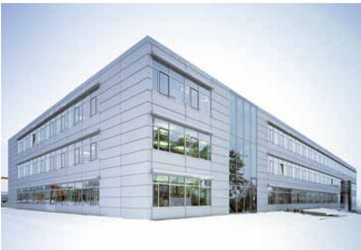
Abbildung 2.10: Ausgewogener Fensteranteil bei ei- nem Entwicklungs- zentrum. (Foto: Dietmar Strauss, Besigheim)
