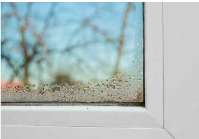
Abbildung 2.7: Feuchte Ränder an Fenstern sind ein Alarmzeichen für zu hohe Innenraumfeuchte. (Foto: Christoph Gross/stock.adobe.com)
