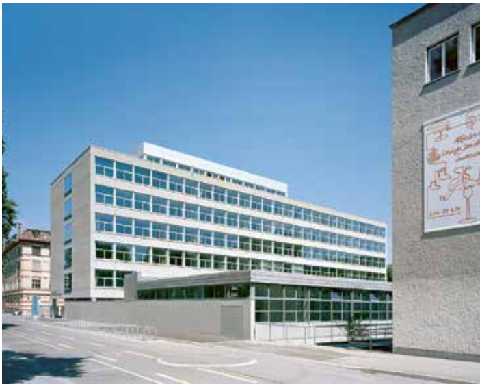
Abbildung 6.9: Der Altbau der Technischen Berufsschule, Zürich (Foto: Hochbauamt Kanton Zürich)
