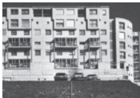
Wohnhaus für die Stadt Lausanne Lausanne, 1985 Architekten: Guy Collomb, Marc Collomb, Patrick Vogel
