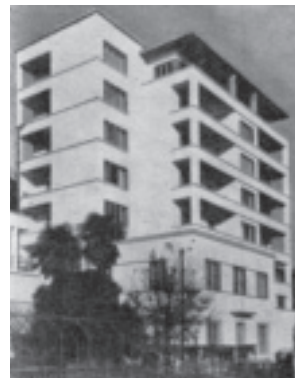
Wohnhaus «Pax» Lugano, 1934 Architekt: Augusto Guidini
