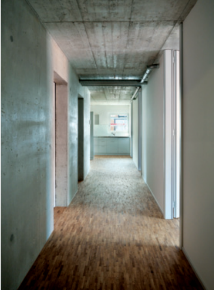
Sichtbare Zuluftkanäle führen von einem zentralen Kern in die einzelnen Räume: Wohnsiedlung Burgunder, Bern
