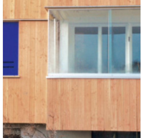
Balkonverglasung und dezentrale Zuluftöffnungen: Erneuerung Wohngebäude, Konolfingen/BE
