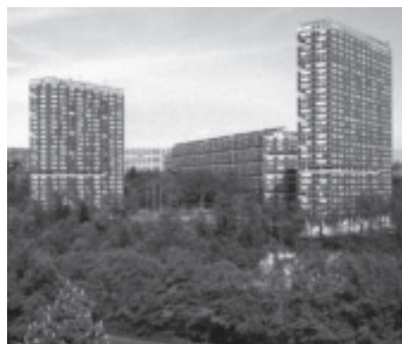
Cité du Lignon Le Lignon bei Genf, 1963/1971 Architekten: Georges Addor, Jacques Bolliger, Dominique Julliard, Louis Payot
