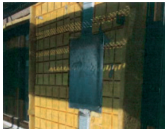
Realisiertes Beispiel Prinzip 2: Erneuerung Wohnsiedlung Heumatt, Zürich Zentrale Lüftungsanlage mit in der Fassadendämmung eingelegten Lüftungskanälen
