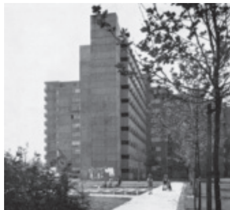
Überbauung «Grüzefeld» Winterthur, 1965/1968 Architekten: Claude Paillard und Peter Leemann
