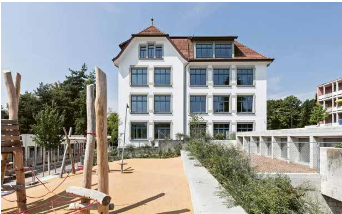
Aussenansicht des erneuerten Schulhauses Bläsi in Zürich-Höngg.
