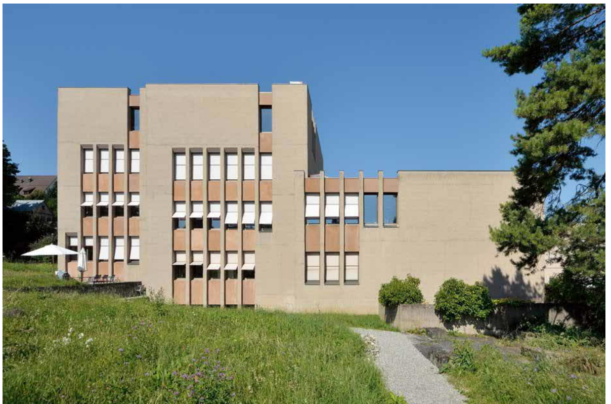
Die Fassadenfenster stellen die visuelle Verbindung zur Aussenwelt sicher.
