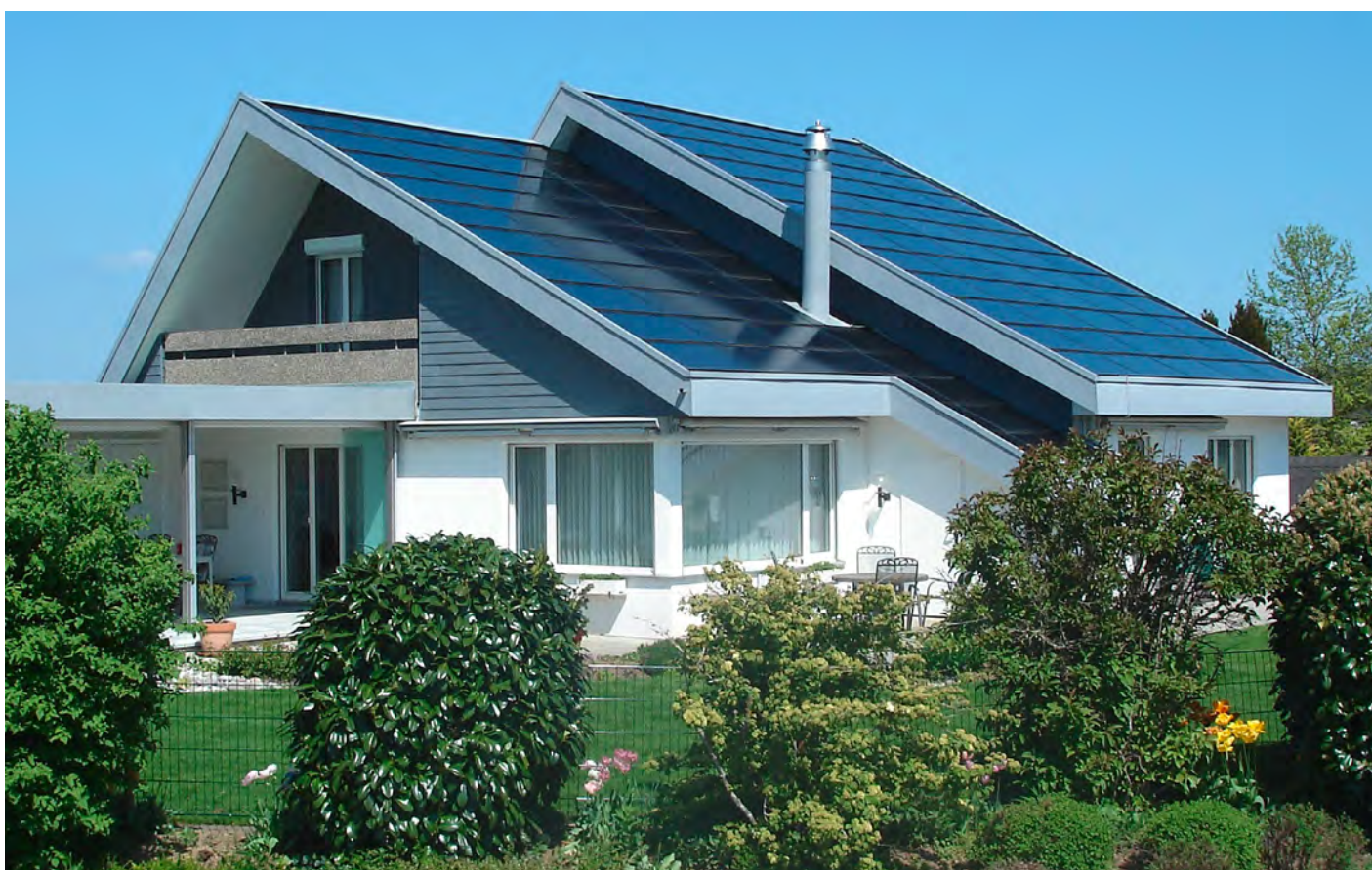
Bei der Sanierung des Einfamilienhauses in Giebenach wurde die Ölheizung durch eine Wärmepumpe ersetzt. Einen Teil des benötigten Stroms produziert neu eine vollflächige, dachintegrierte Photovoltaikanlage. Quelle: EnergieSchweiz
