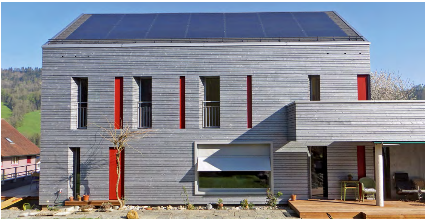
Eine umfassende Sanierung wie bei diesem Einfamilienhaus in Malterts ist in der Regel nach 40 bis 50 Jahren nötig. Quelle: EnergieSchweiz
