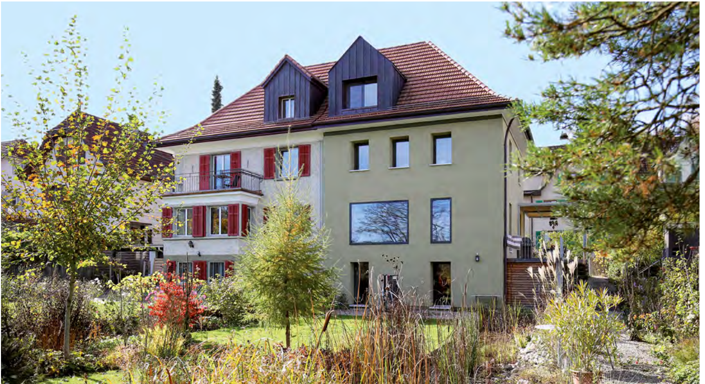
Sanierungen nach dem Minergie-Standard wie bei diesem Minergie-P-Einfamilienhaus in Olten können förderberechtigt sein. Quelle: EpprechtArchitekten AG, Aarburg
