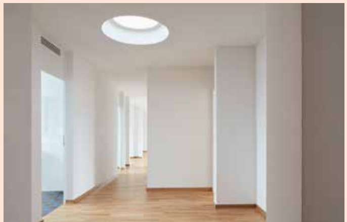
Bild 3.11: Über den Durchlass oberhalb der Badezimmertüre (links) gelangt die Zuluft in den Korridor. Bei konventioneller Luftführung wäre eine heruntergehängte Decke erforderlich gewesen, die das Oblicht verdeckt hätte. (Quelle: Ralph Feiner)
