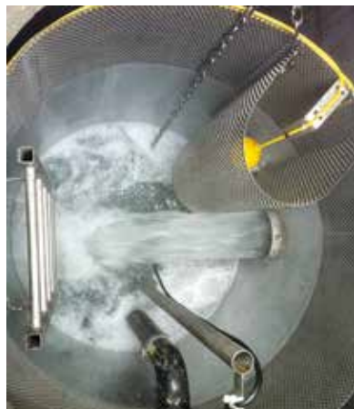
Schachtwärmetauscher
