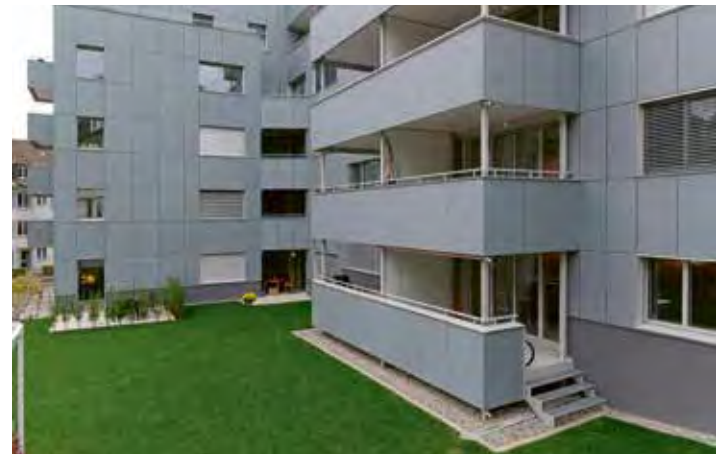
Bild 9.3: Grau bedruckte PV-Module, geschuppt verlegt. (Quelle: Stiftung Umweltarena Schweiz)
