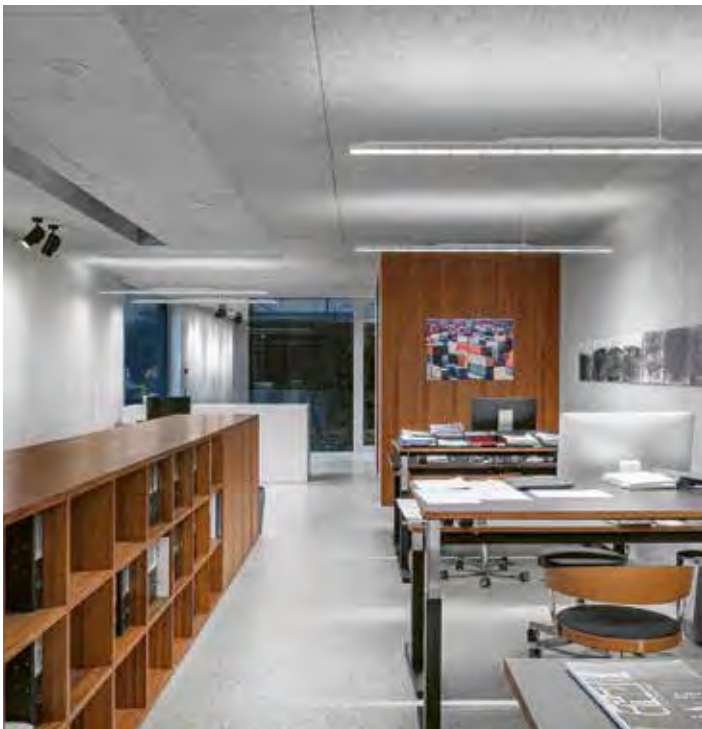
Bild 6.3: Lichtlösung mit einer Mischung aus Pendelleuchten über den Arbeitsplätzen und präzise positionierter Aufbaustrahler, die die Wände beleuchten. (Foto: Zumtobel)
