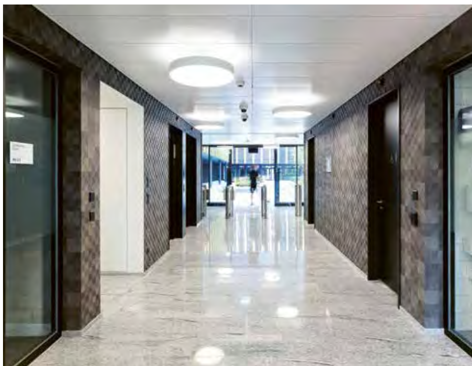
Abbildung 8.41: Die intelligenten Leuchten erhöhen das Sicherheitsempfinden. Dank Schwarmverhalten läuft das Licht über mehrere Leuchten mit. (Bild: Swisslux)
