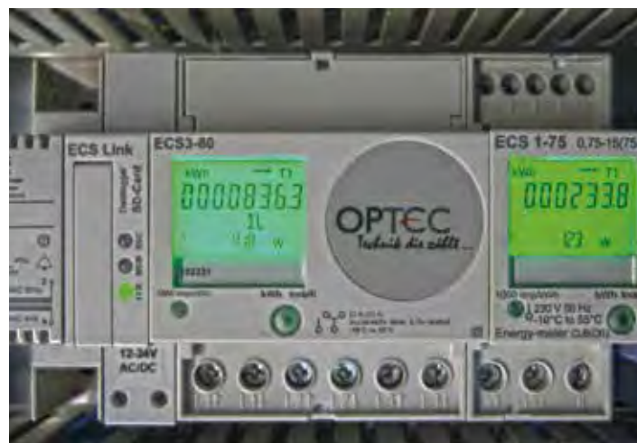
Abbildung 6.22: Energie- und Leistungsmessgerät mit Datenlogger für SD-Karte.
