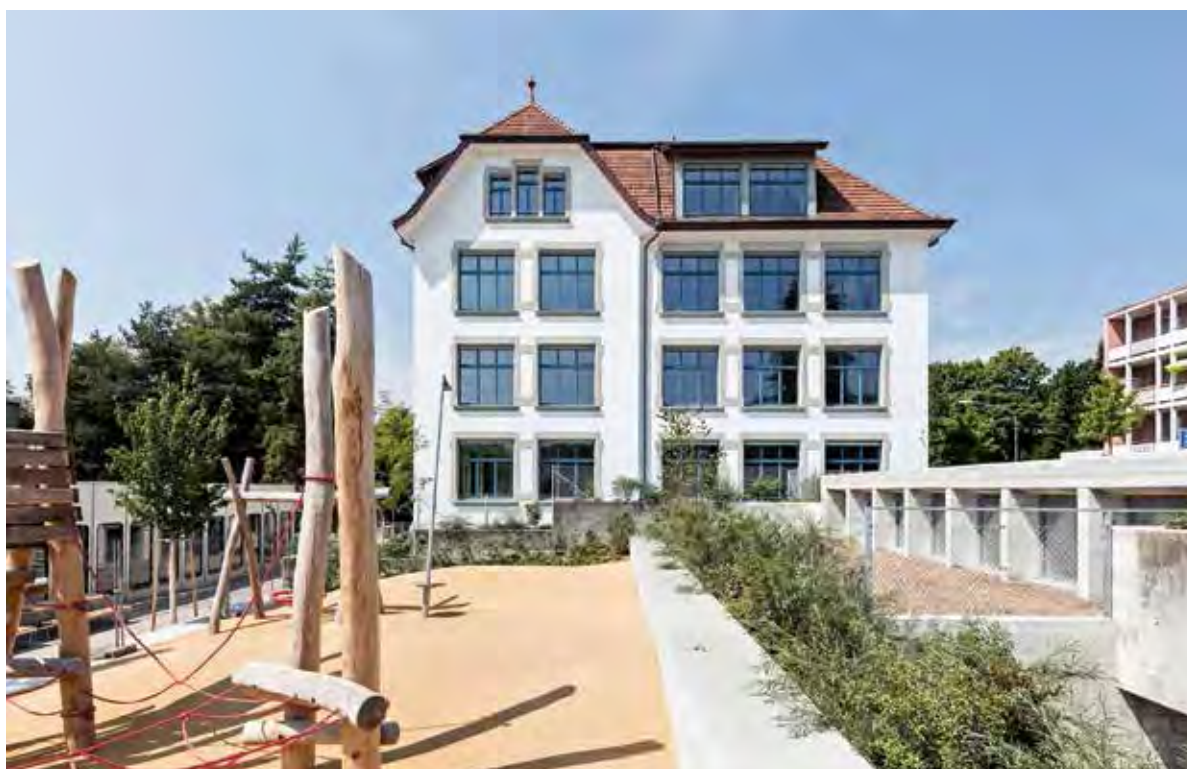
Abbildung 8.29: Aussenansicht des erneuerten Schulhauses Bläsi in Zürich-Höngg.
