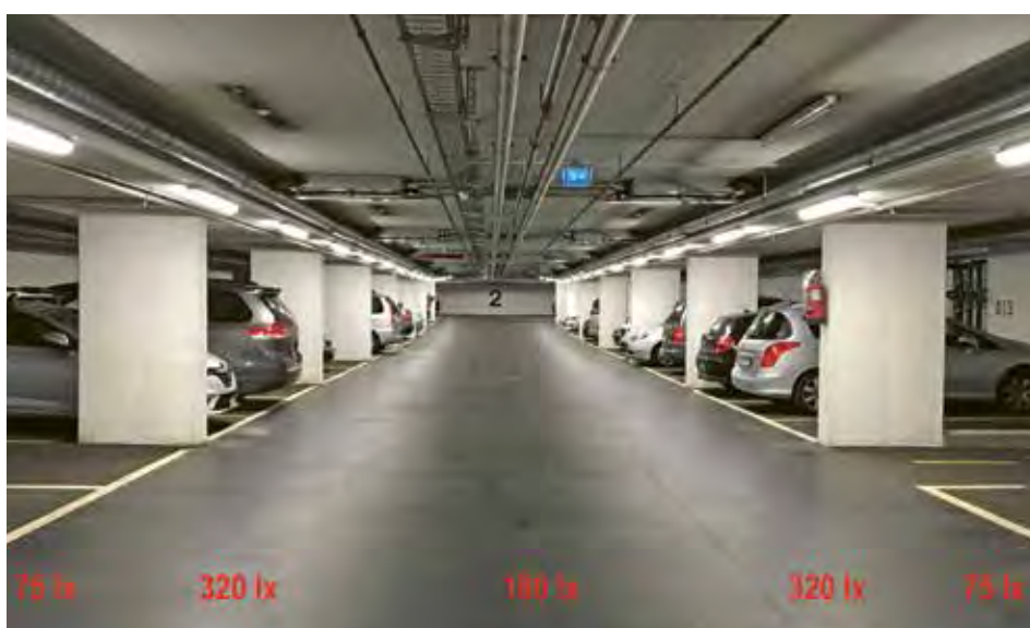
Abbildung 6.20: Die Beleuchtung und die gemessene Beleuchtungsstärke nach der Erneuerung.
