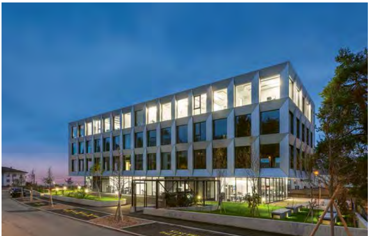
Abbildung 8.36: Aussenansicht des Bürohauses Pallin in Pully. (Bild: Regent)
