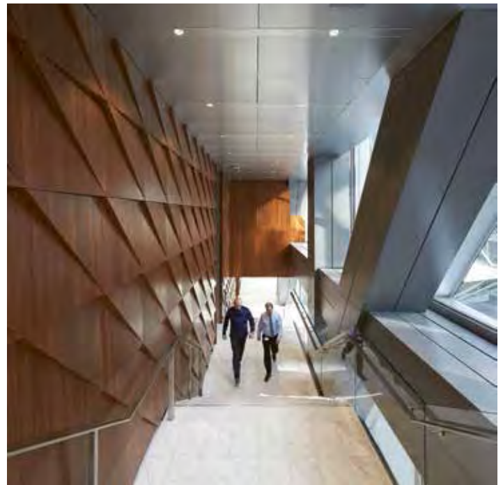
Abbildung 8.28: In den Korridoren und Treppengebieten sind Downlights in die Decke eingelassen. (Quelle: Hufton and Crow)
