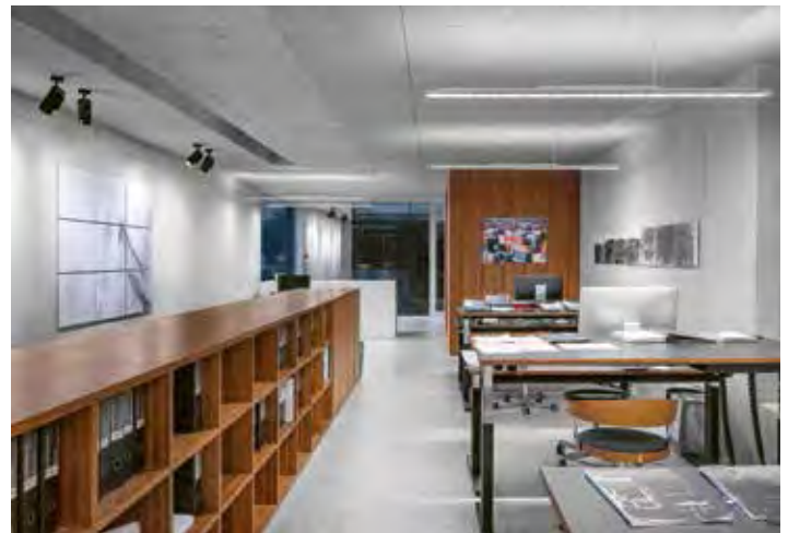
Abbildung 8.33: Büro Lichtkonzept: Pendelleuchten/ Aufbaustrahler. (Bild Zumtobel)
