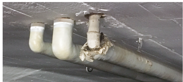
Defekte Wärmedämmungen reparieren.
