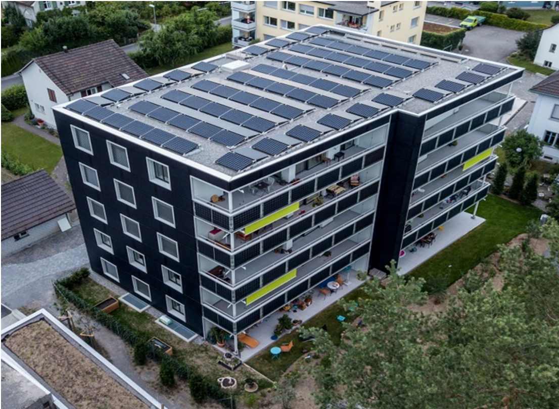
Abbildung 42: MFH in Wetzikon AG mit PV-Anlagen auf Dach und Fassaden (Quelle: Arento AG)
